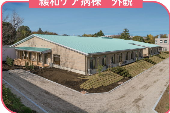
緩和ケア病棟 外観
