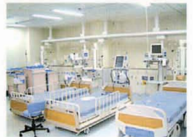
患者管理用 モニター類は最新式で、シーリング方式(天床よりつり下げ)となっている
